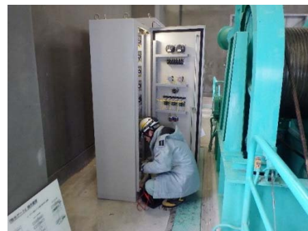
取水塔内の電気操作盤点検状況
