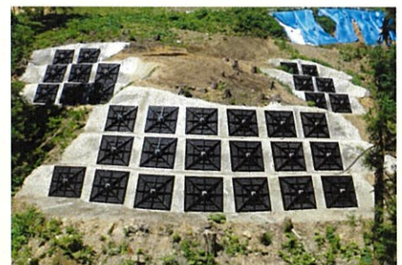
アンカー工で施工した山腹工
