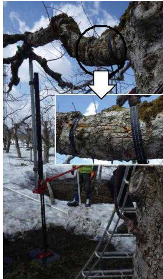
図6 ジャッキアップ後の裂開部の接合
