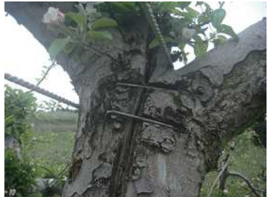
図3 カスガイ利用による裂開部固定
