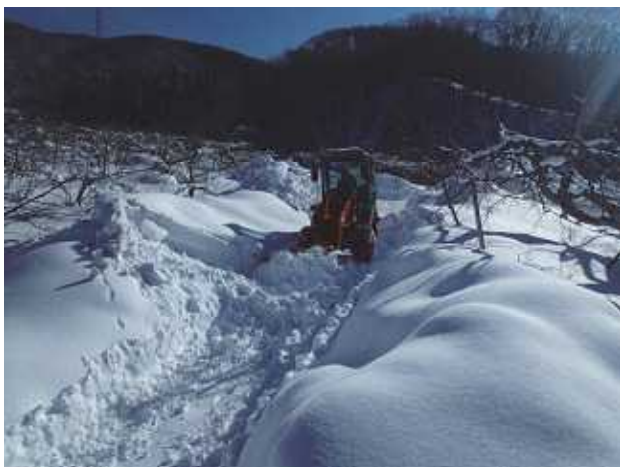
平成27年2月5日の作業状況
