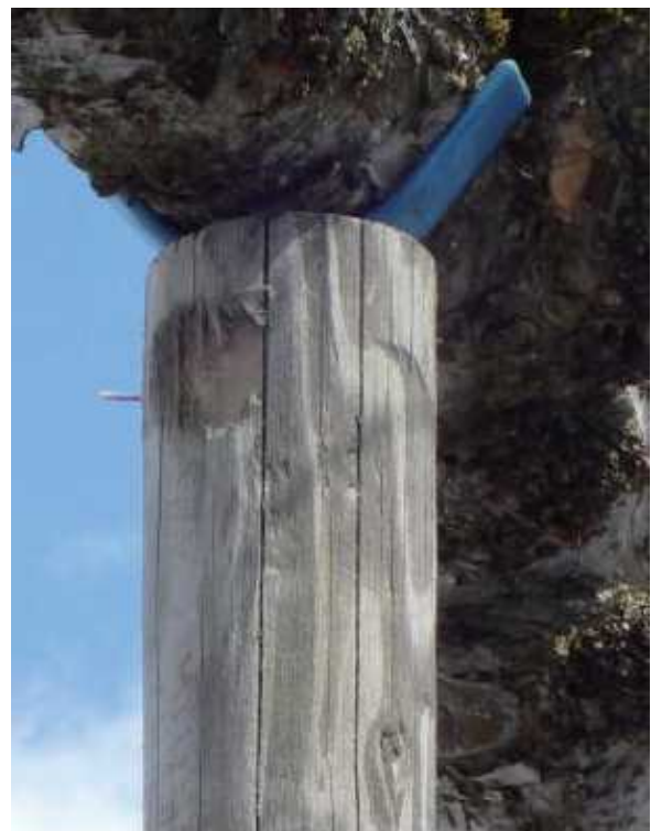
図9 支柱の設置(上部)
