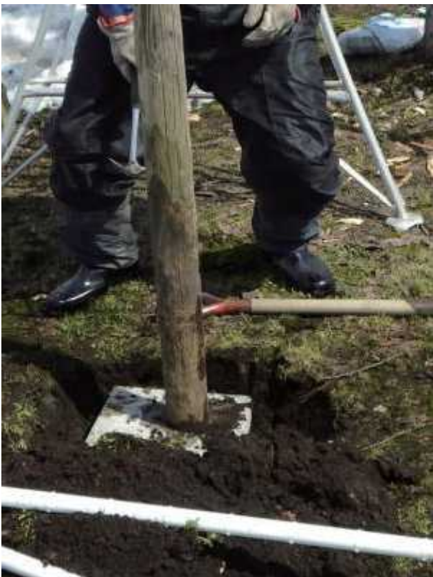
図8 支柱の設置(下部)
