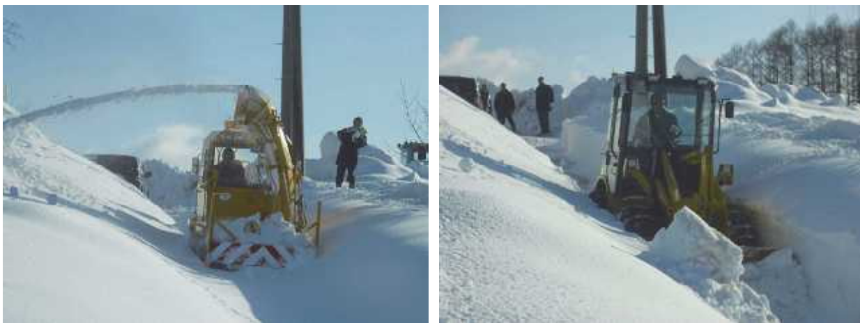
ロータリー除雪機で除雪後、ホイールローダーで拡幅除雪している
