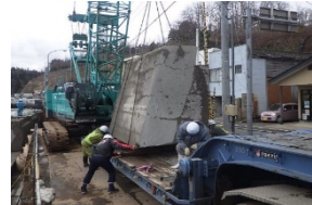
ワイヤーソーによる切断・撤去
