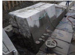
ワイヤーソーによる切断・撤去
