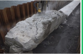
割岩機による取壊し
