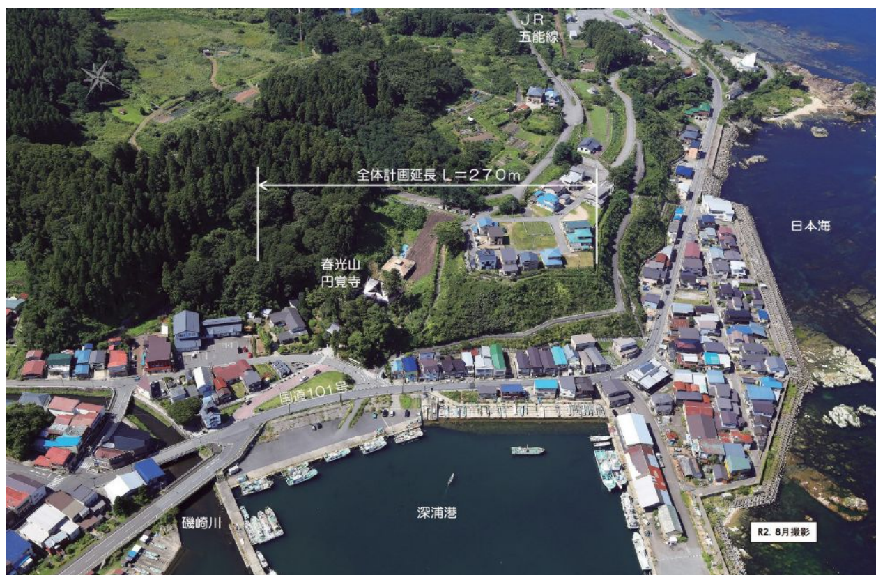
岡崎2号区域急傾斜地崩壊対策事業（深浦町）
