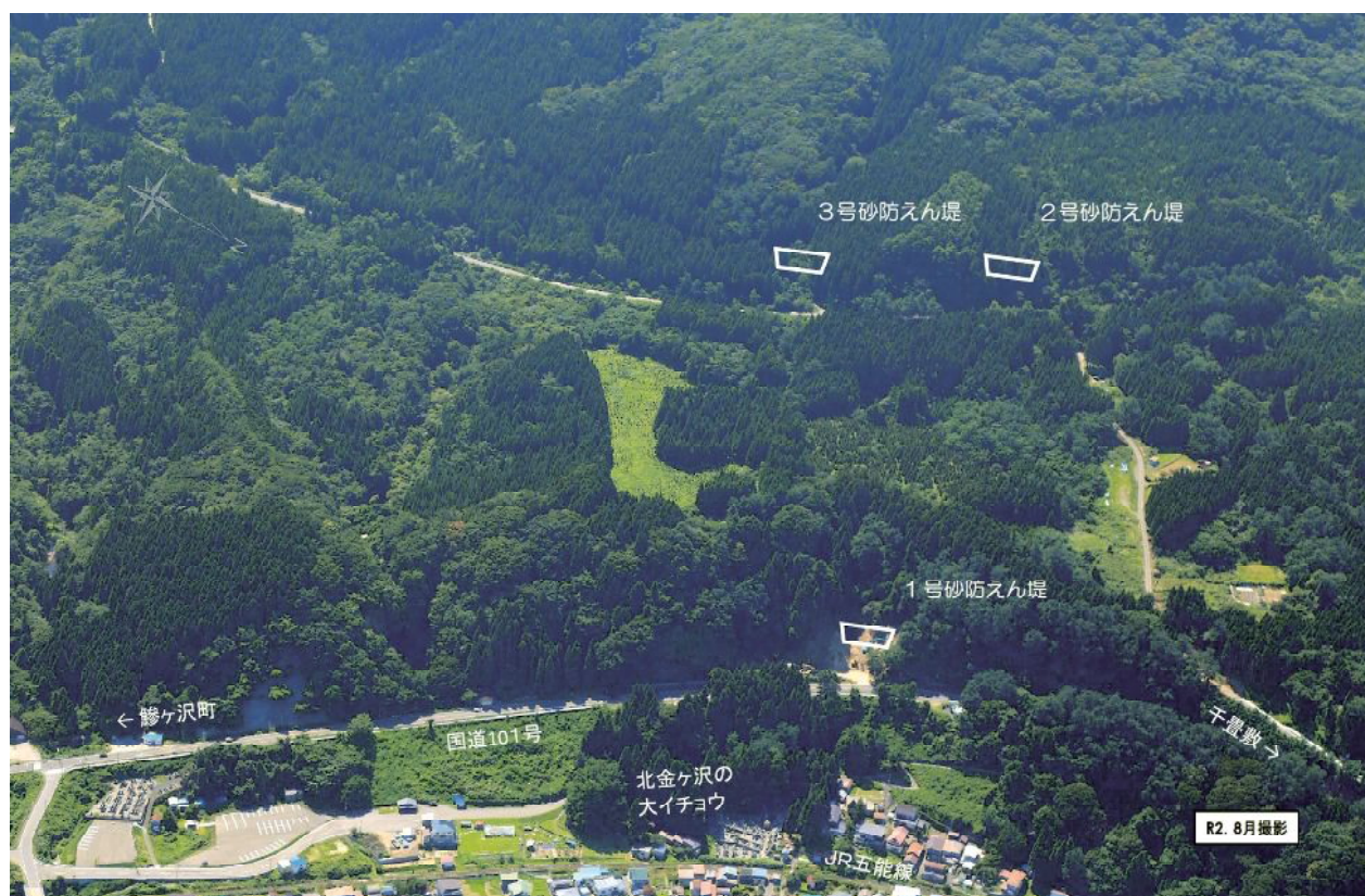
トモエ沢砂防えん堤(深浦町)
