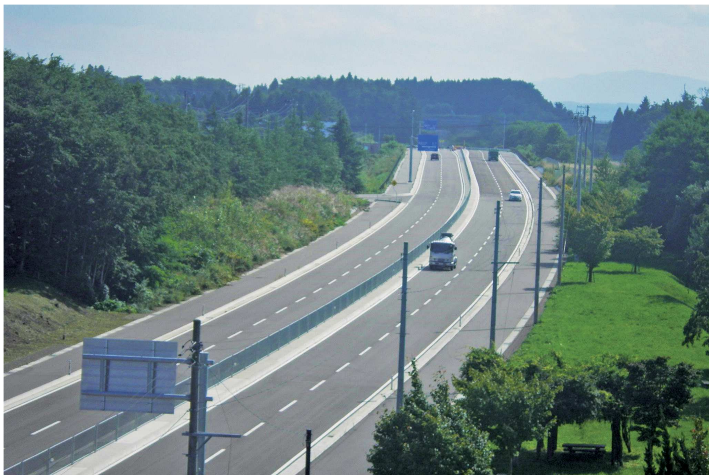
八戸環状線(天久岱工区)
