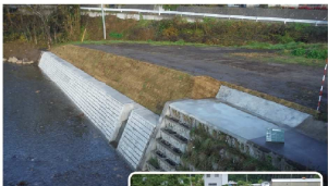
一般河川馬淵川 新築工区 河川災害復旧事業 (田子町)
