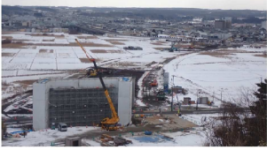
主要地方道八戸環状線 天久岱工区 道路改修事業 (八戸市)
