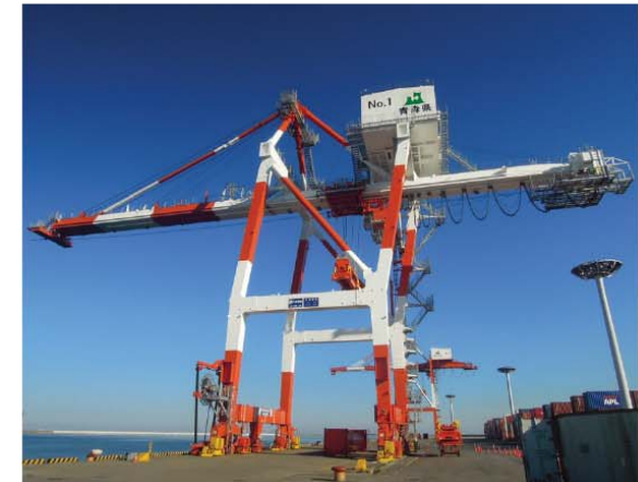
橋型クレーン
