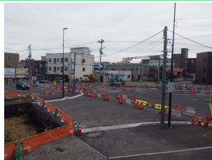
作業ヤード規制
