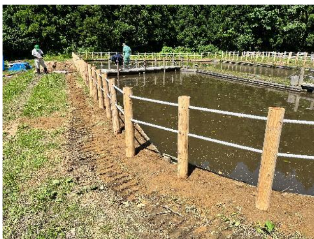
転落防止柵設置の様子
