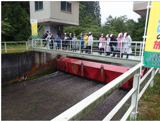
洪水吐ゲートから放流する様子
