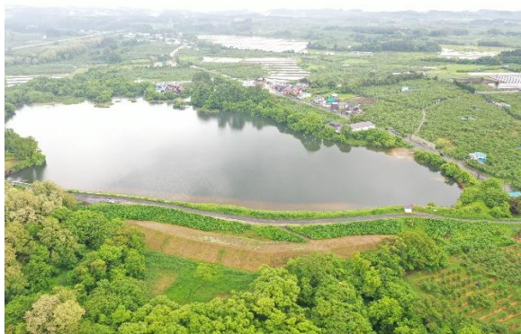
ため池等整備事業 (高野大溜池地区 五所川原市 R1～R3)
