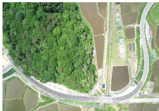
広域営農団地農道整備事業 道路工 (西海岸関地区 深浦町 H28～R5)
