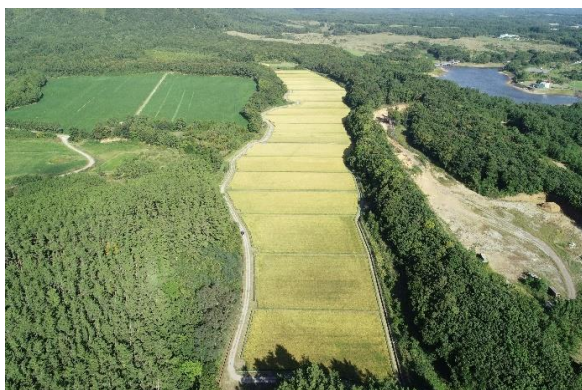
経営体育成基盤整備事業 区画整理工 (磯松地区 五所川原市 H25～R2)
