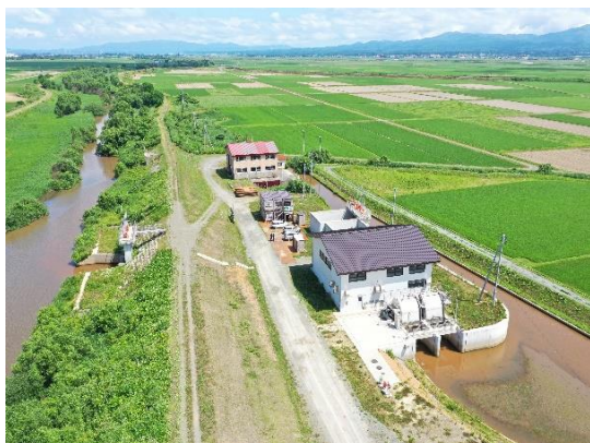
農業水利施設保全合理化事業 (小田川南部地区 森内排水機場 五所川原市 H27～R6)
