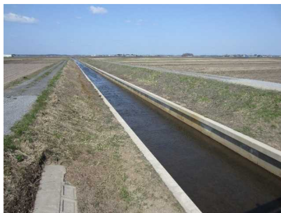
県営岩木川左岸 3 期地区かんがい排水事業により整備を行った水路
