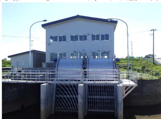
県営小田川南部地区農業水利施設保全合理化事業により整備を行った金木排水機場
