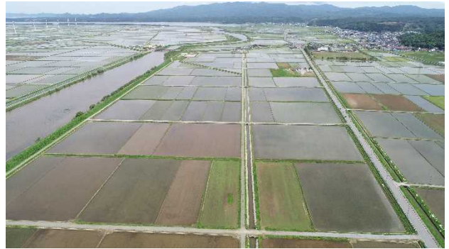
大区画ほ場整備を進めている十三湖地区
