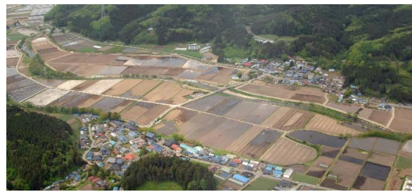
原・飯豊地区（田子町） 施工：平成25, 26年度 地下かんがいシステム施工面積：30.9ha
