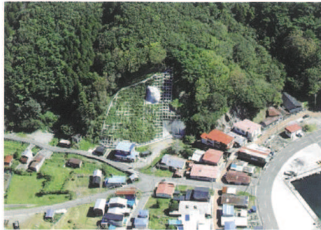
九艘泊区域急傾斜地崩壊対策事業（むつ市脇野沢九艘泊）現場打吹付法枠工
