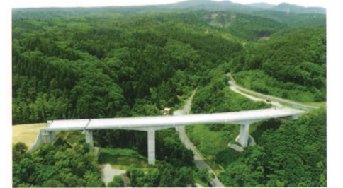
国道279号 二枚橋バイパス
