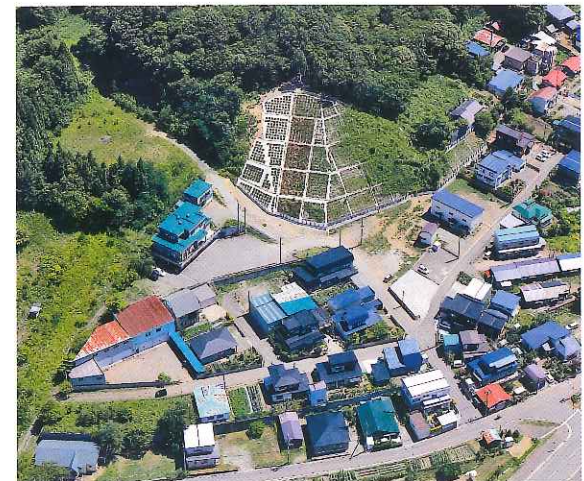
船橋区域急傾斜地崩壊対策事業（野辺地町）
