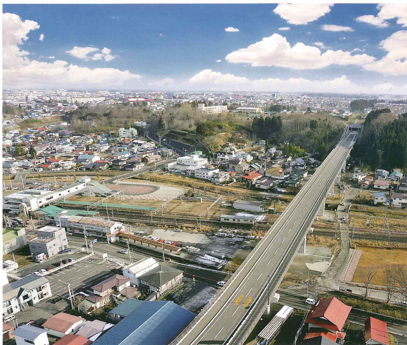
(写真：3・4・3号中央町金矢線：三沢大橋)
