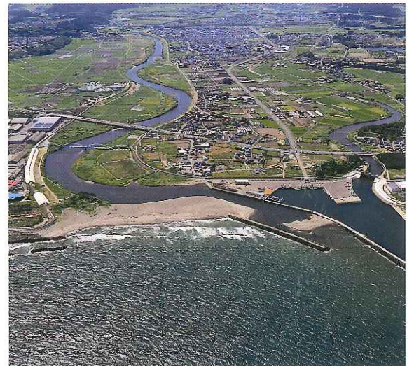
奥入瀬川地震高潮対策河川事業（おいらせ町）
