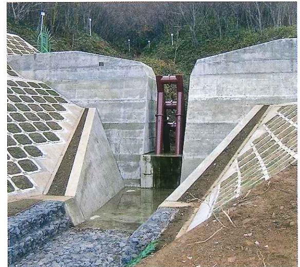
中六ヶ所沢総合流域防災事業（六ヶ所村）
