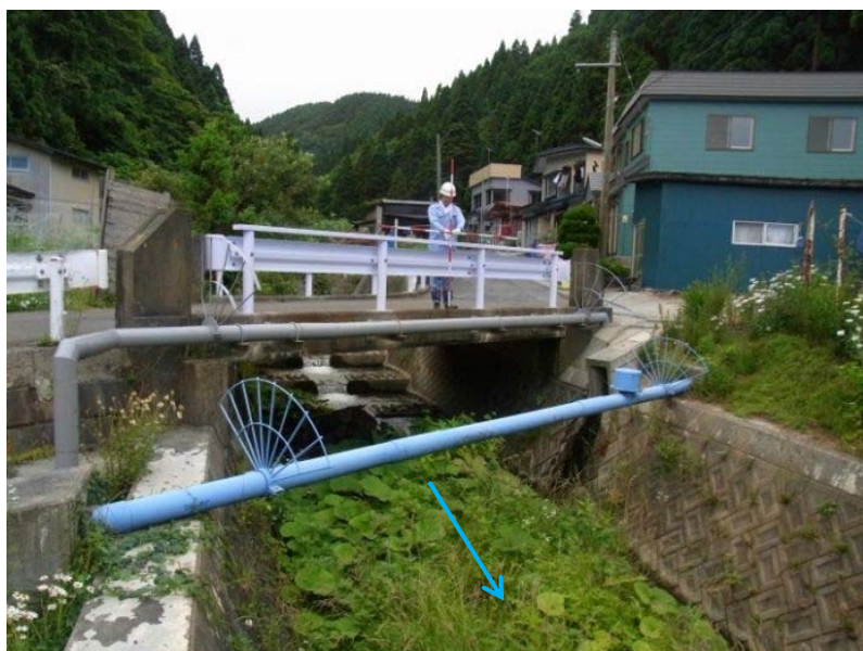
町道橋下流部
