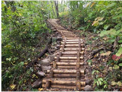
二股コースに新設した迂回ルート（木製階段工）
