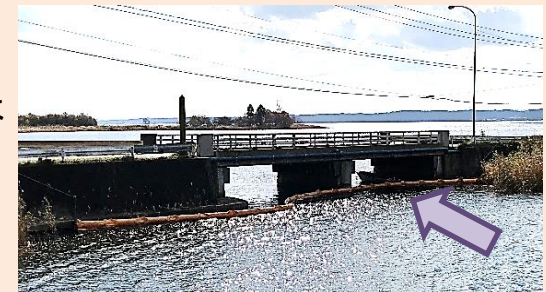
内沼と本湖の接続部付近に設置したフェンス
