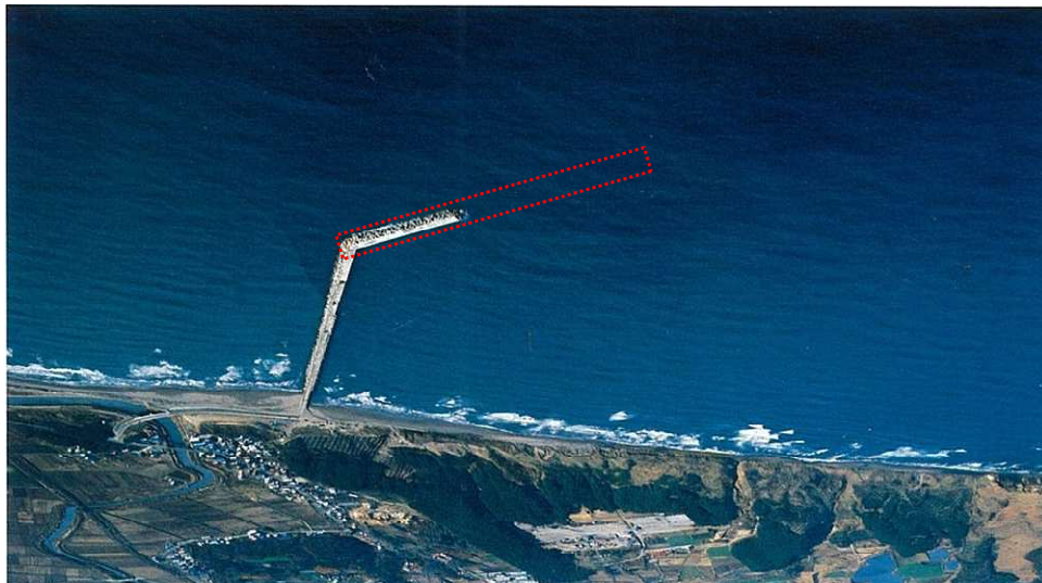
【整備前】 ※写真は平成4年
