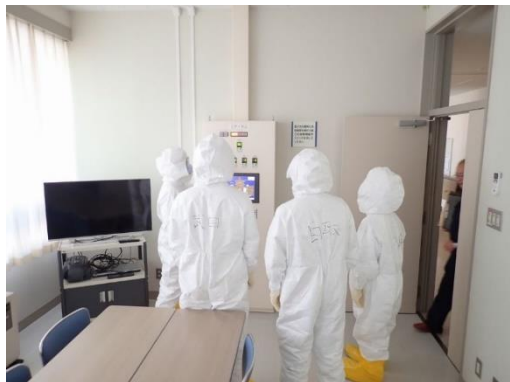
【放射線防護設備稼働】
