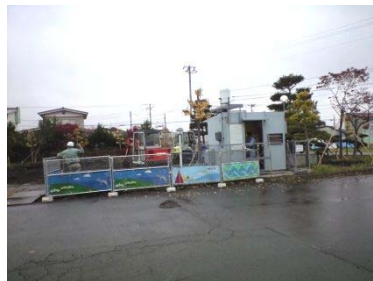
写真2：周辺環境変化後 （工事中：H21.11.10撮影）
