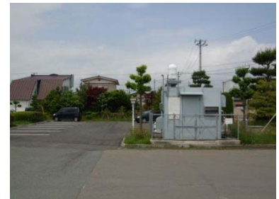
写真3：周辺環境変化後 （工事終了後：H22.6.22撮影）
