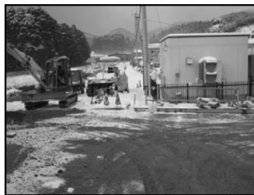
写真2 周辺環境変化後 (工事中:H23.12.19 撮影)
