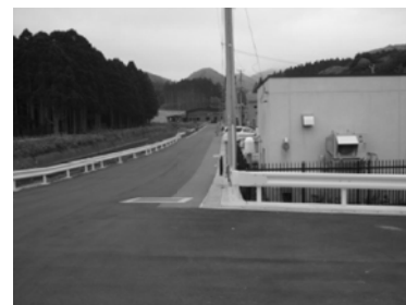
写真3 周辺環境変化後 (工事後:H24.5.21 撮影)
