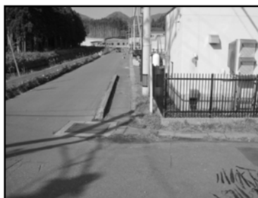
写真1 周辺環境変化前 (工事前:H23.11.1 撮影)
