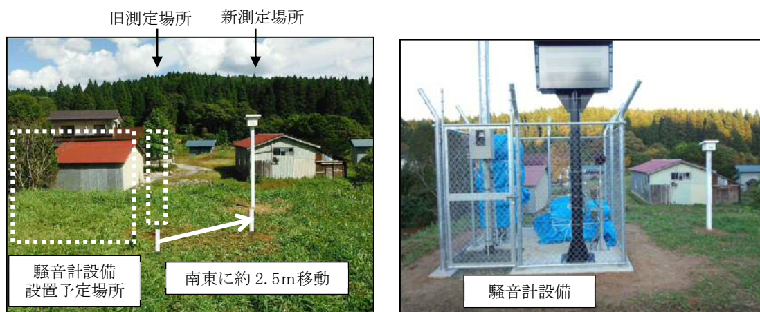
写真1 新測定場所・騒音計工事前 平成25年9月26日撮影
