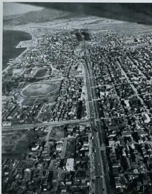
昭和44年11月10日撮影の旧線路跡 （旧線は市街地の中央を貫いていた（県史編纂グループ所蔵））
