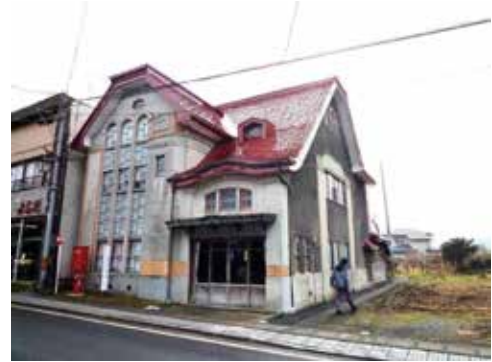
建造物のパトロールの様子 登録有形文化財 村井家住宅（南部町）
