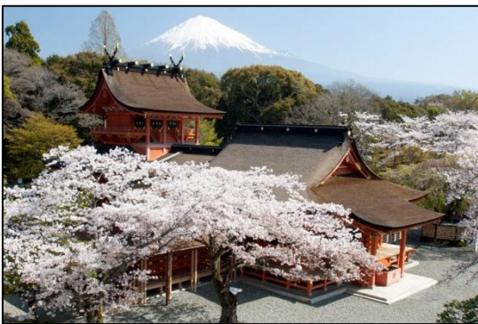
写真13 富士山本宮浅間大社 （本殿：国指定重要文化財）
