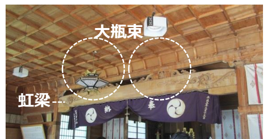
写真11 拝殿の格天井部分
