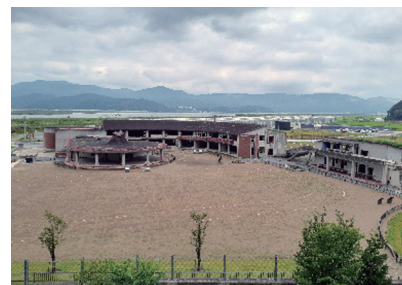
震災遺構大川小学校 (宮城県石巻市)
