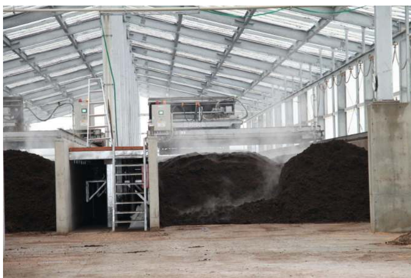
堆肥化施設（スcoop式、六ヶ所村）
