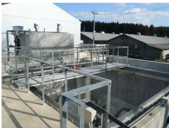
処理槽及び管理棟
