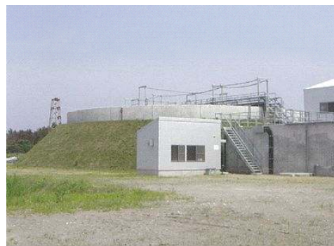
浄化処理施設（三沢市）
