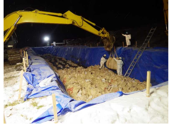
⑥2022. 12. 18 (2時頃) フレコンバッグの投入作業 2
