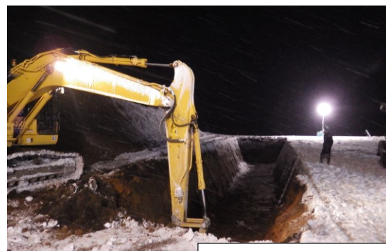
雪の中での作業状況
