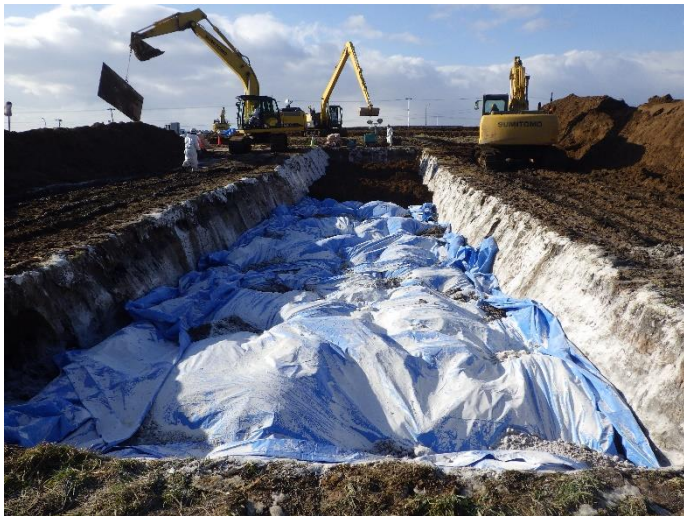
③2022. 12. 23 (13-14 時) 埋却作業の様子 1
