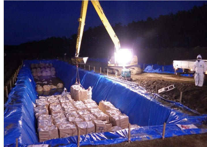
④2022. 12. 23 (16-17 時) 埋却作業の様子 2
