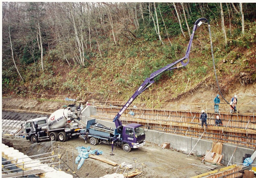
魚道 コンクリート打設状況
