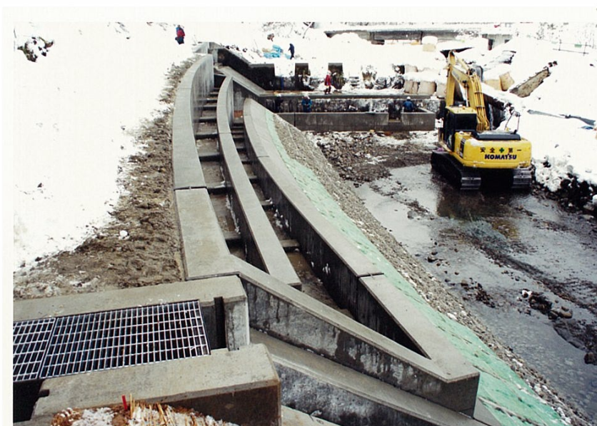
魚道 コンクリート打設完了
