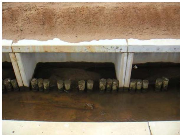
写真説明 コンクリート二次製品水路を縦にして内側に向け、これを並べて配置することで湾処を形成。
