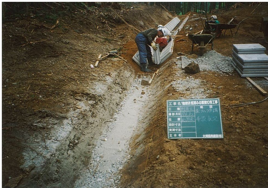
張ブロック据付状況
