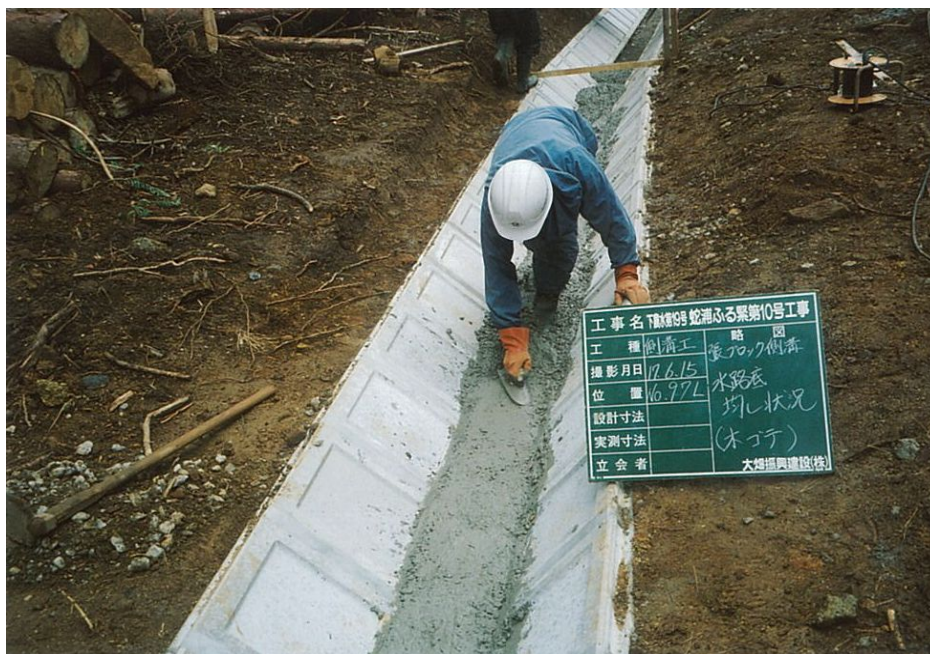
インバートコンクリート仕上状況
