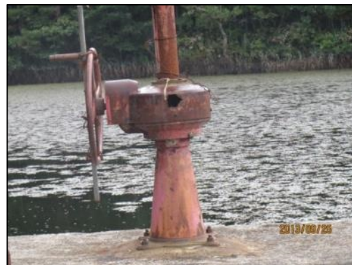
ゲート巻き上げ機の破損事例
