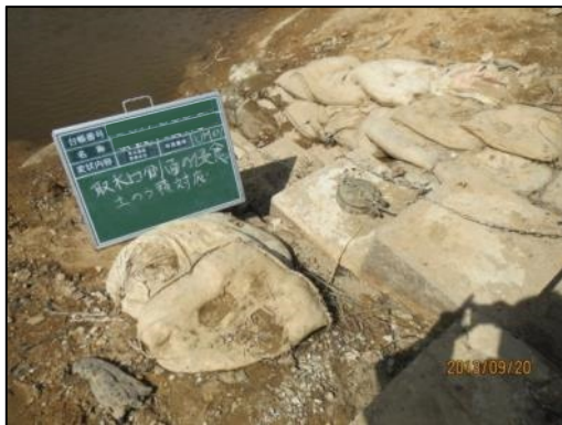
土のうで補修した事例
