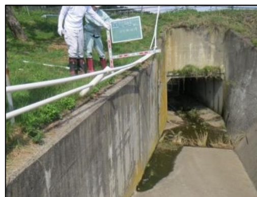
安全柵が破損している例
