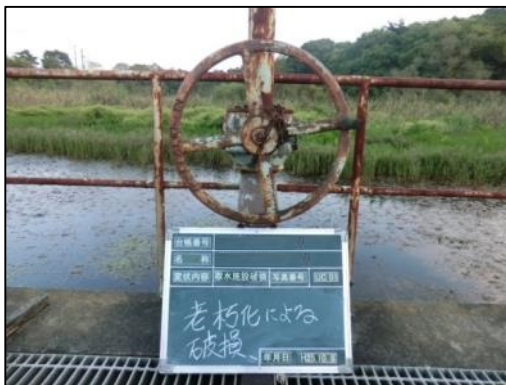
ゲート巻き上げ機の破損事例
