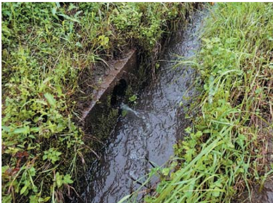
「田んぼダム」実施 流出量が少ない （令和4年8月9日 蓬田村）
