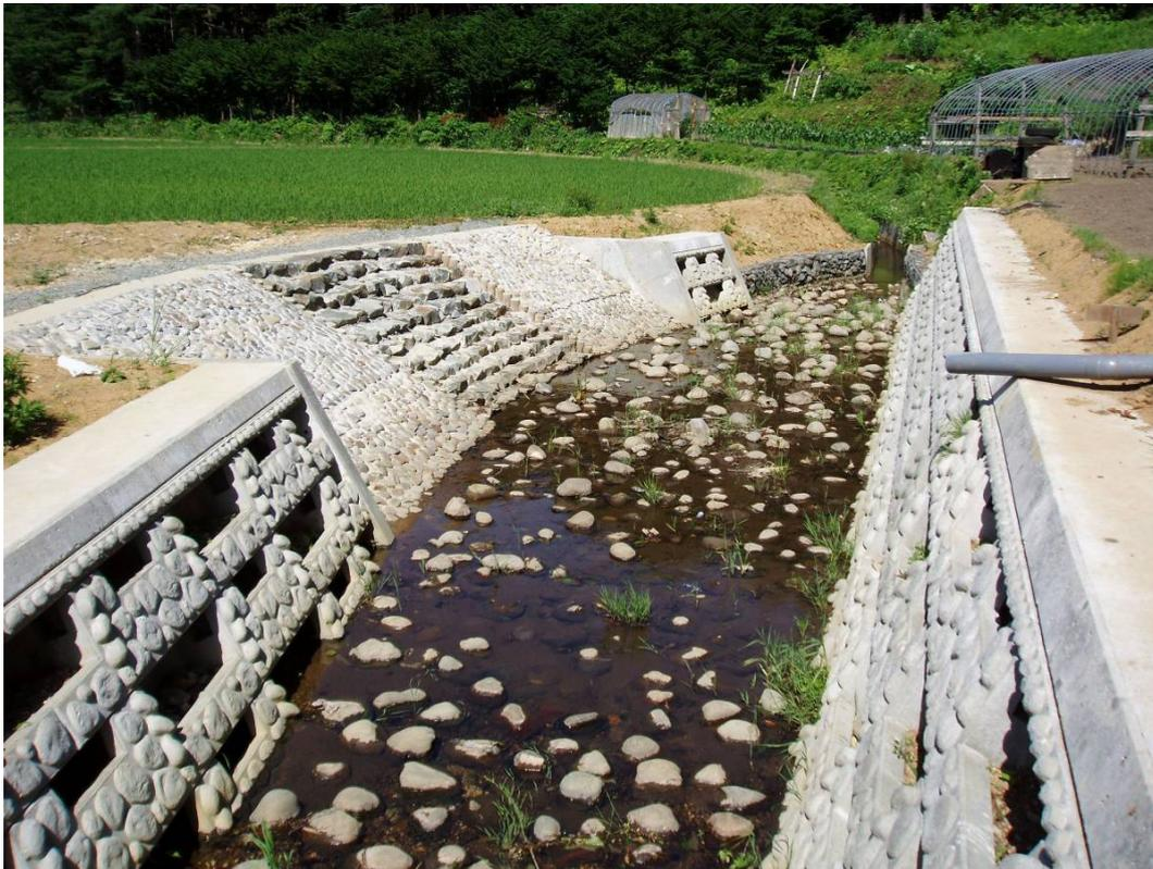
写真説明 生態系保全エリア(石張り護岸、フンカゴ、魚巣ブロック)
