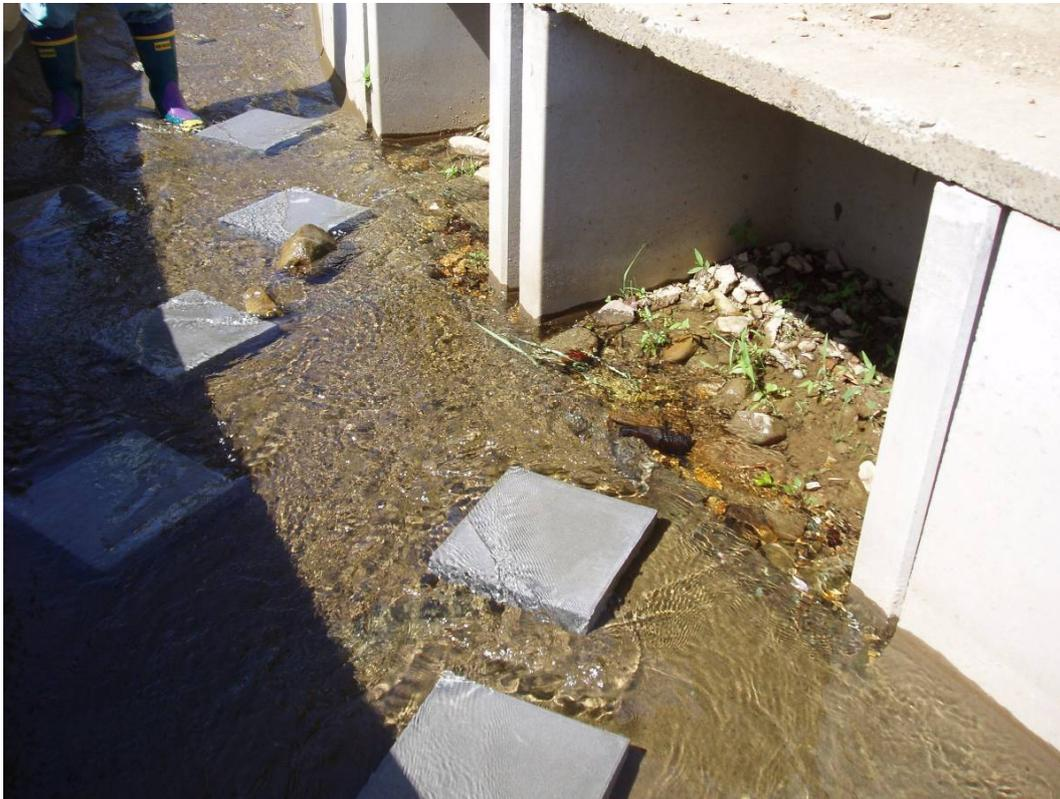
写真説明 生態系保護施設(湾処)、排水フリユームや柵渠パネル現地発生材を利用した
