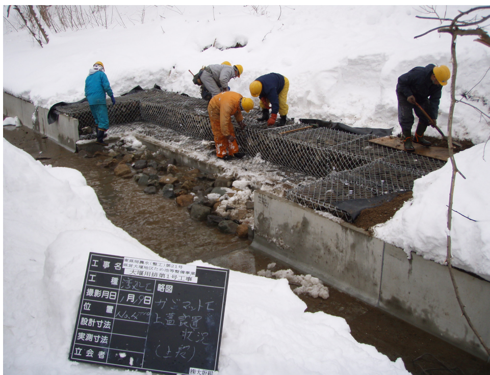
湾処② 蓋版設置状況
