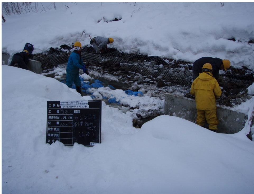
湾処① 既設側溝取付状況
