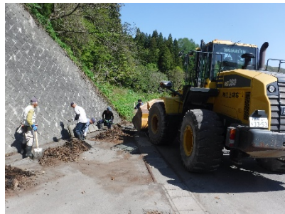
【共同作業(水路の泥上げ)】
