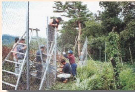
共同で電気柵の設置
