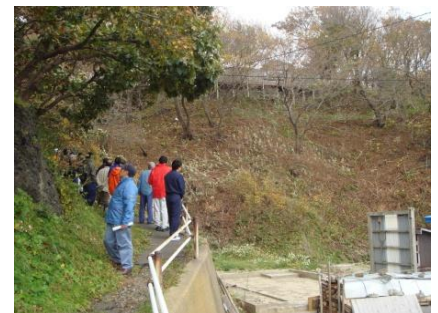
人家裏の急傾斜地の状況確認
