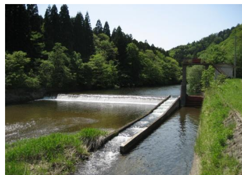
現在の大畑頭首工（改修前）
