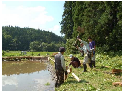
協議会による擁壁作りの様子
