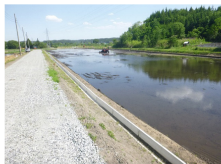
整備後のほ場
