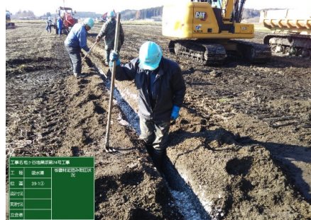
ホタテ貝殻を活用した暗渠排水の整備
