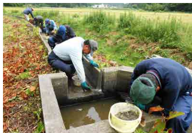
共同作業による水路補修
