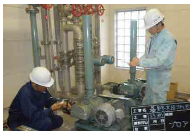
集落排水施設の機能診断
