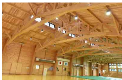
公共建築物への県産材利用
