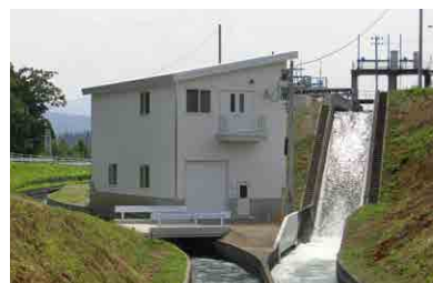
三本木地区小水力発電施設
