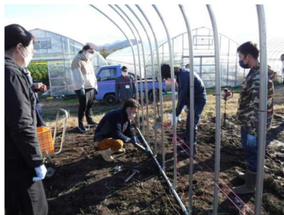
パイプハウス建て方研修会の様子
