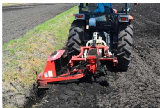
実証ほの額ぶち明きょ施工
