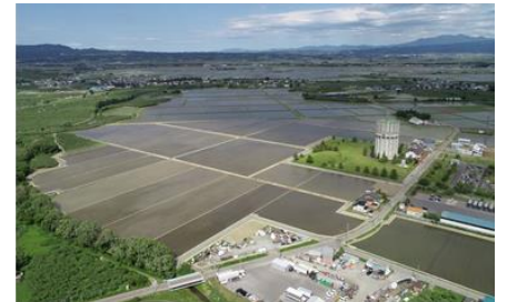
【大区画ほ場整備(板柳町・深味長野地区)】
