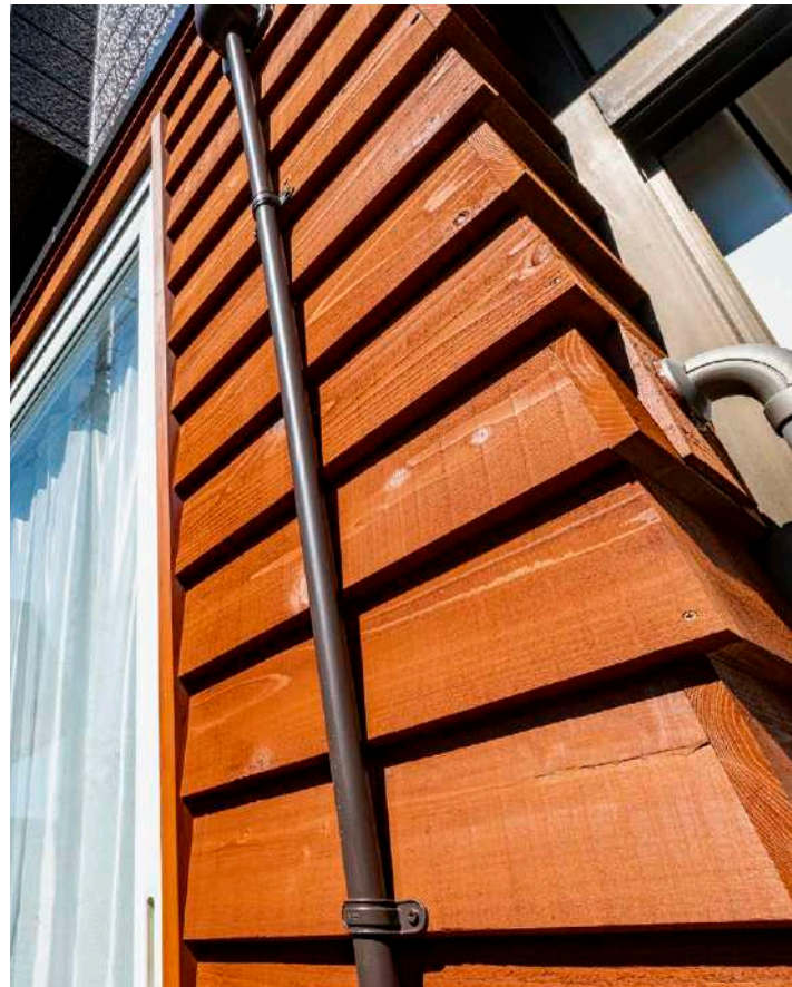
青森県産杉板を使用し、ブラウンカラーに塗装した外壁。 メンテナンスも容易にできる
