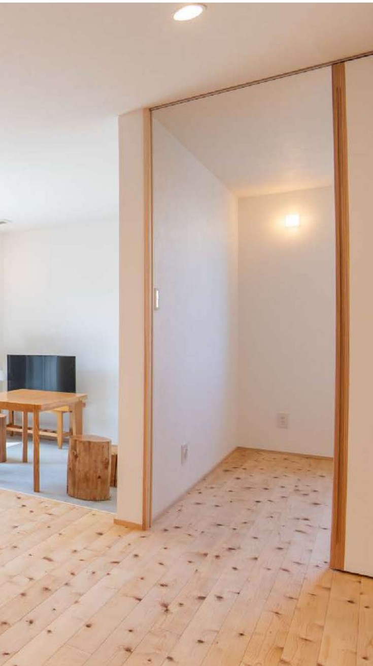
リビングから土間と予備室を見る。床に張られたヒバ材のフローリングは、部屋ごとに見切り材で分かれていないので段差がなく歩きやすい。
