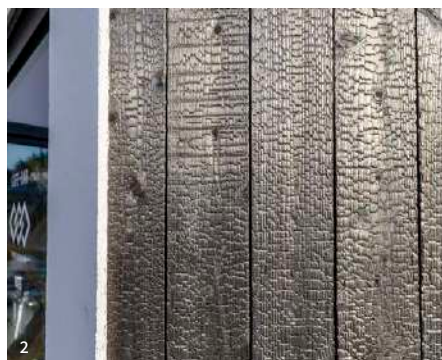
1. 斜めに大きく突き出た屋根を支えるアカマツの梁。2. 塗装では出せない濃淡が味わい深い焼スギ。3. 屋根の模様は南部裂織を彷彿とさせる。
