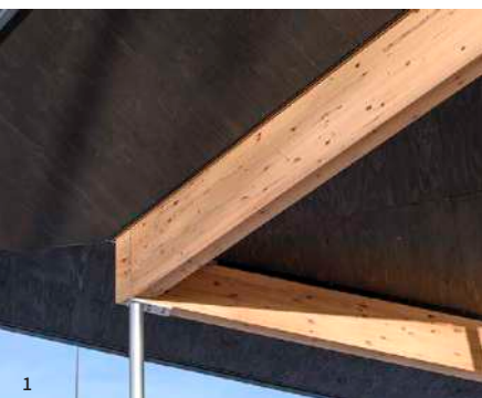
1. 斜めに大きく突き出た屋根を支えるアカマツの梁。2. 塗装では出せない濃淡が味わい深い焼スギ。3. 屋根の模様は南部裂織を彷彿とさせる。
