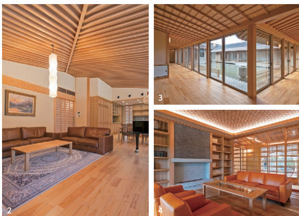
1.節目も割れもなく見事な天井板と、それを支える柱と梁。2.若いご夫婦のLDK。天井の垂木は、高いところで長さ3.5mにおよぶ。3.正面玄関を入ると広がる光景。4.応接間の天井はスギの柱を市松に編んでおり、間接照明が美しい凹凸を照らす。
