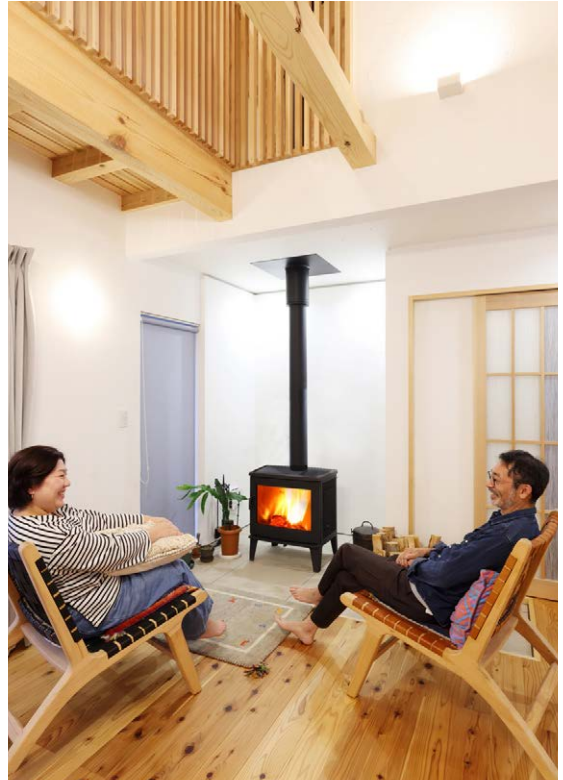
小型の薪ストーブ1基だけで冬でも家全体が温かくなるという。 煙突は2階を突き抜けて直線的にすることで、メンテナンスもしやすい
