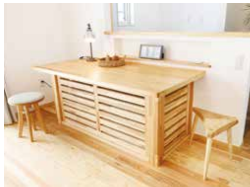
テーブルの下にエアコン本体を収納し、建具で目隠し
