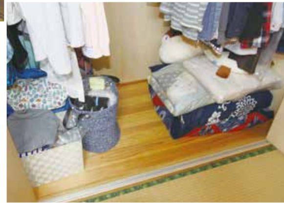
押入れの床下に防湿シートを敷設し、床組みにも防湿シートと板状の発泡断熱材を敷き、壁・天井にも断熱材を入れ、吸湿効果のあるスギ板を床に敷いた
